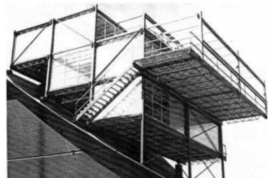
Figura - Experimento com o sistema “TEST”, de Helmut Shulitz (Shulitz, 1979). Este sistema de estrutura montável/desmontável é composto de peças disponíveis no mercado da construção civil de Los Angeles do início da década de 1970. Permite flexibilidade por ser um sistema “aberto”, tomando elementos de maneira relativamente livre. O que define o sistema é a abordagem de utilização destes elementos. (Shulitz, 1979, p.149-151)
